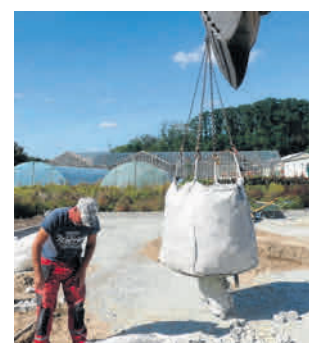
Prace budowlane zostaną ukończone w listopadzie
