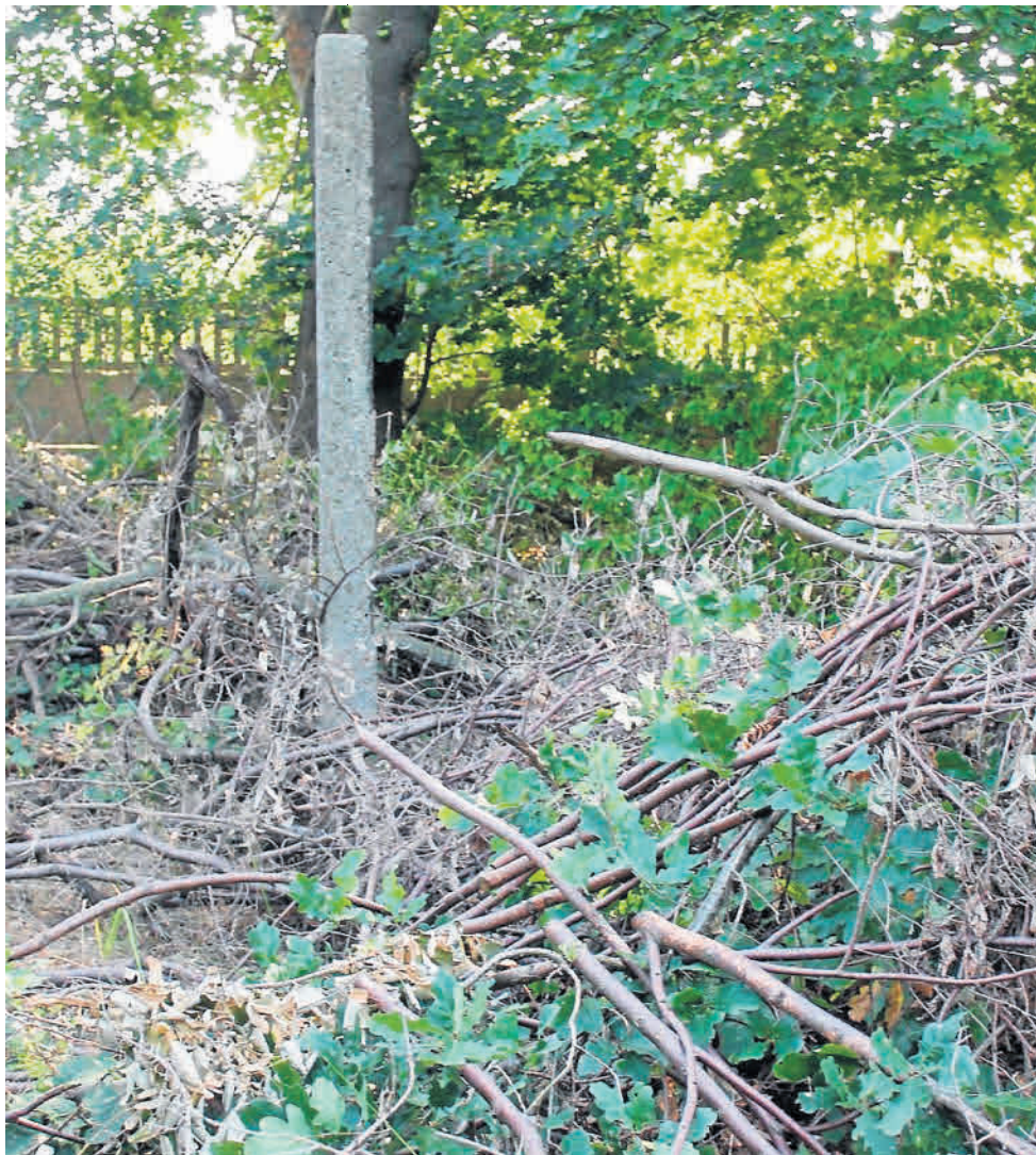
Od kilku dni na wojskowym terenie przy ul. 5 Stycznia, obok lotniska Ławica, trwa wycinka drzew i krzaków pod rozbudowę Muzeum Broni Pancernej. Okoliczni mieszkańcy są oburzeni
