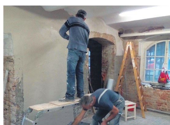
Centrum Integracji Społecznej w Rogoźnie wykonuje m.in. zadania remontowo - budowlane
