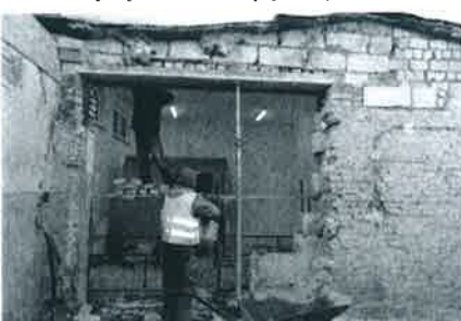
CIS w Rogoźnie w trakcie prac remontowych
